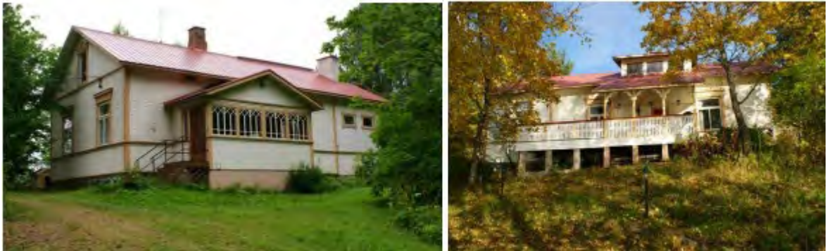
Kuva 22 Rauhalanrannan huvilan pohjoispäätyyn on tehty jälkeinpäin laajennusosa. Lasikuistissa on vanhoja ikkunoita, mutta betoniperustus ja ulko-ovi ovat myöhemmältä ajalta. Vanhaa verantaa on jatkettu. (kuvat: Kulttuuriselvitystyö Ahola)
