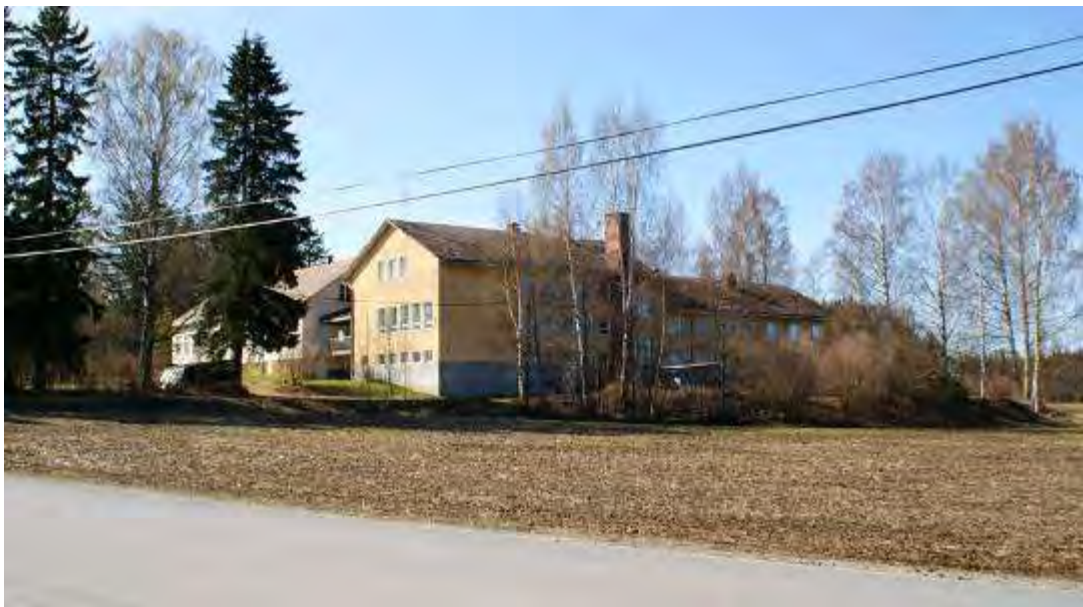
Kuva: Entinen Ristiinan kunnalliskodin päärakennus.
