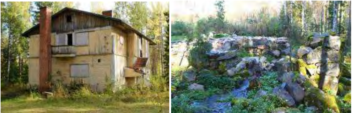
Kuva: Honkaharjun tulipalossa vahingoittunut huvila. Vesikatko on tehty palon jälkeen.
