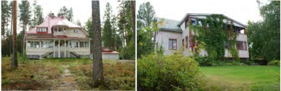
Kuva 20 Vasemmalla Auralan huvilarakennus ja oikealla Rantalan harjakattoinen huvilarakennus. (kuvat: Kulttuuriselvitystyö Ahola)
