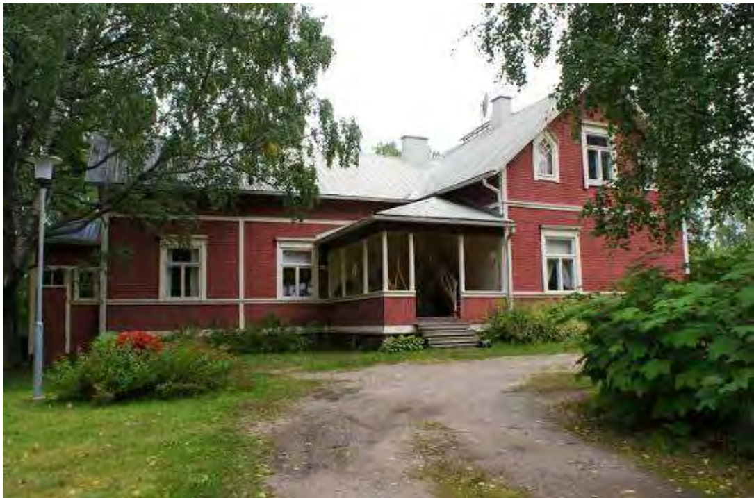
Kuva: Rauhaniemen huvila. Pihakuisti on uusittu.
