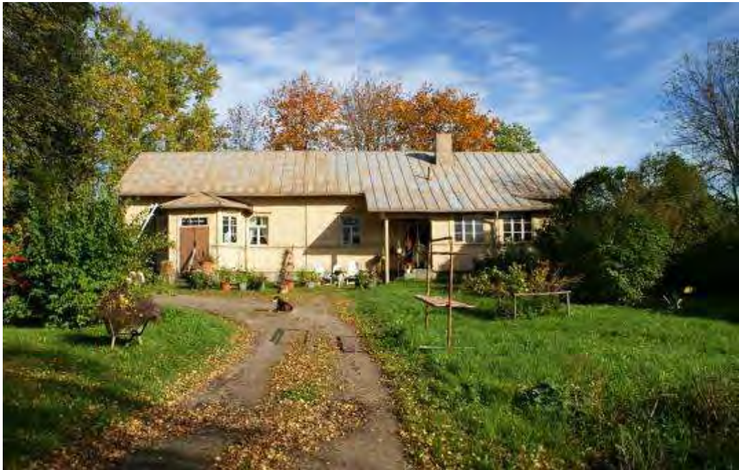
Kuva: Lassilan talonpoikainen päärakennus (1924) on säilyttänyt alkuperäisen tyylinsä. Kookkaan hirsitalon pihanpuoleisella sivulla on kaksi kuistia, joista toinen on ns. mutterikuisti. Julkisivulaudoitus on jaettu kerros- ja pystylistoin erisuuntaisiin kenttiin. Rakennuksen ikkunat ovat 1900-luvun alkupuolella suosittua jugendista vaikutteita saanutta mallia, joka on tavallinen hyvin monissa selvitysalueen vanhoissa rakennuksissa.
