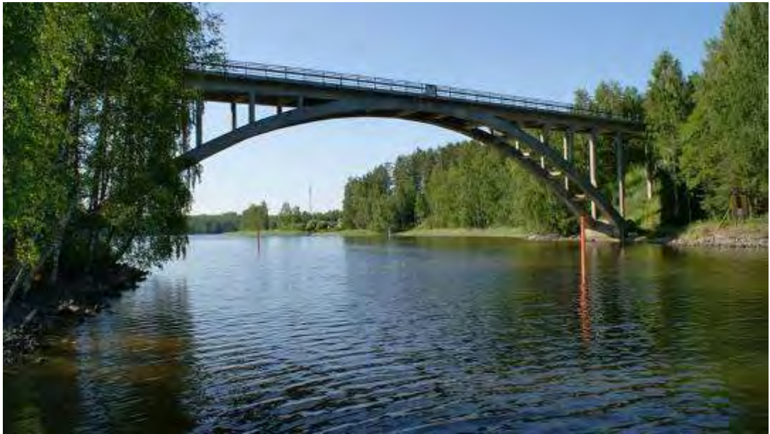
Kuva: Juurisalmen silta.
