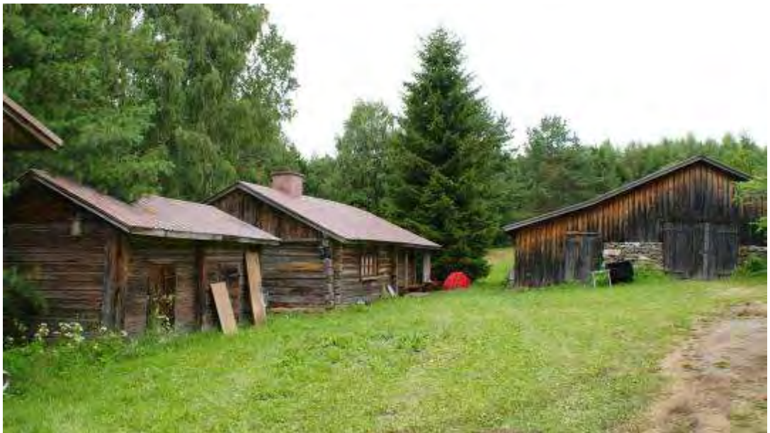
Kuva: Kylän kantataloihin lukeutuvan (Ylä-)Ollin pihapiiri on säilynyt poikkeuksellisen eheänä. Kaikkien rakennusten kattaminen pellillä vuosikymmeniä sitten on säilyttänyt välillä vähälläkin käytöllä olleen rakennusryhmän. Maalaamattomien hirsirakennusten rajaama pihakokonaisuus sisältää iäkkäistä aittoja ja maatalousrakennuksia sekä nyt peruskorjauksen alla olevan vanha matalan hirsitalon. Kuvassa pariaitta ja entinen lampola ja navetta.
