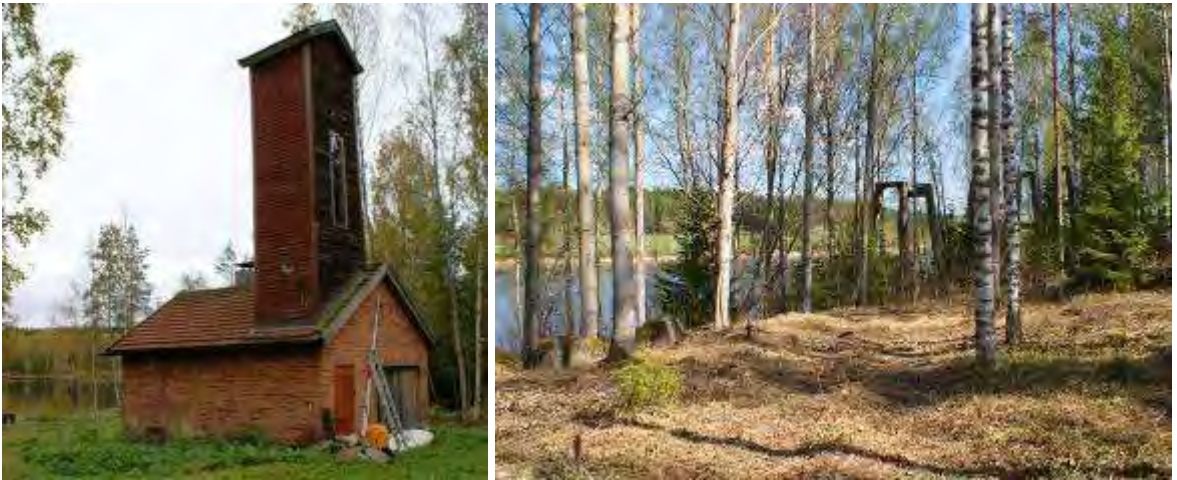
Kuvat: Sahan alueella säilynyt paloasema sekä hakekuljettimen betonipylväät.
