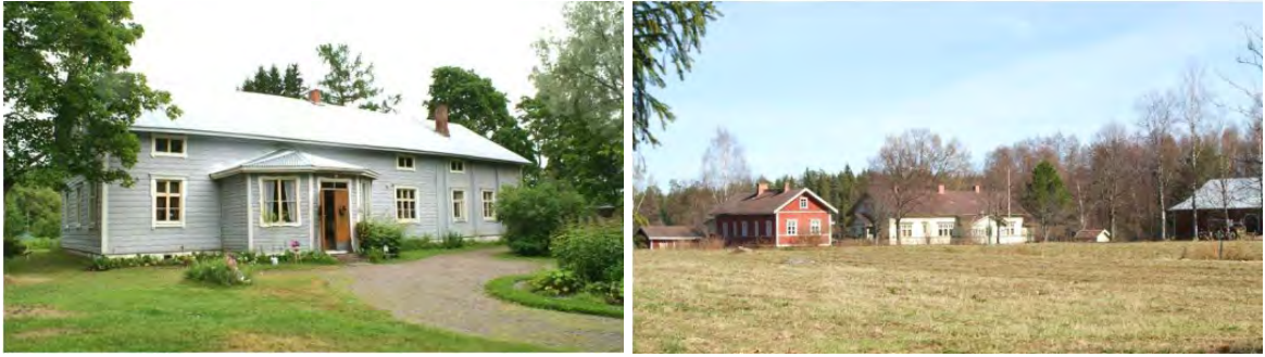
Kuva 21 Vasemmallä Vanha-Peltolan päärakennus ja oikealla Tapiola, entinen kirkkoherran pappila. (kuvat: Kulttuuriselvitystyö Ahola)
